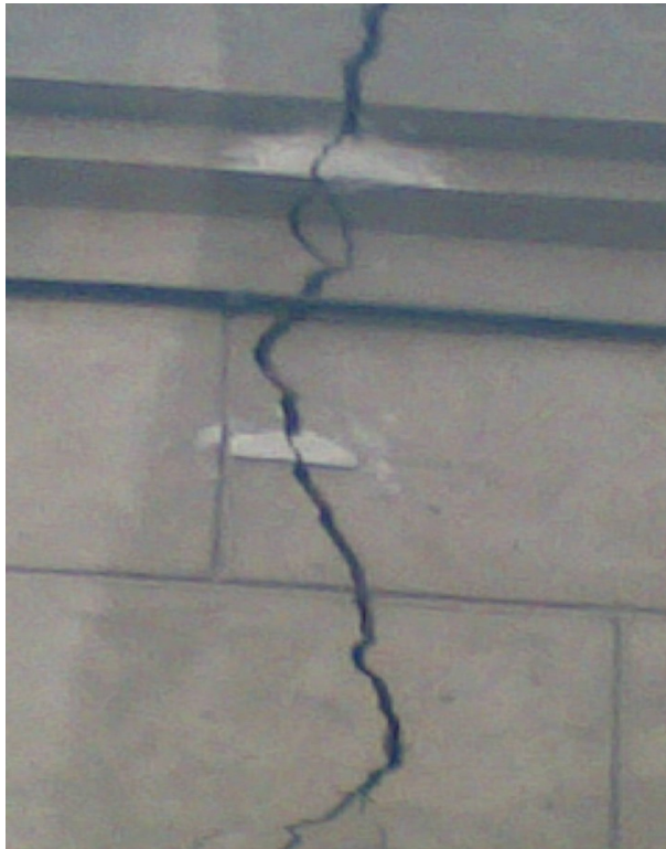
Рис. 4. Перекриття тріщини гіпсовим маяком
