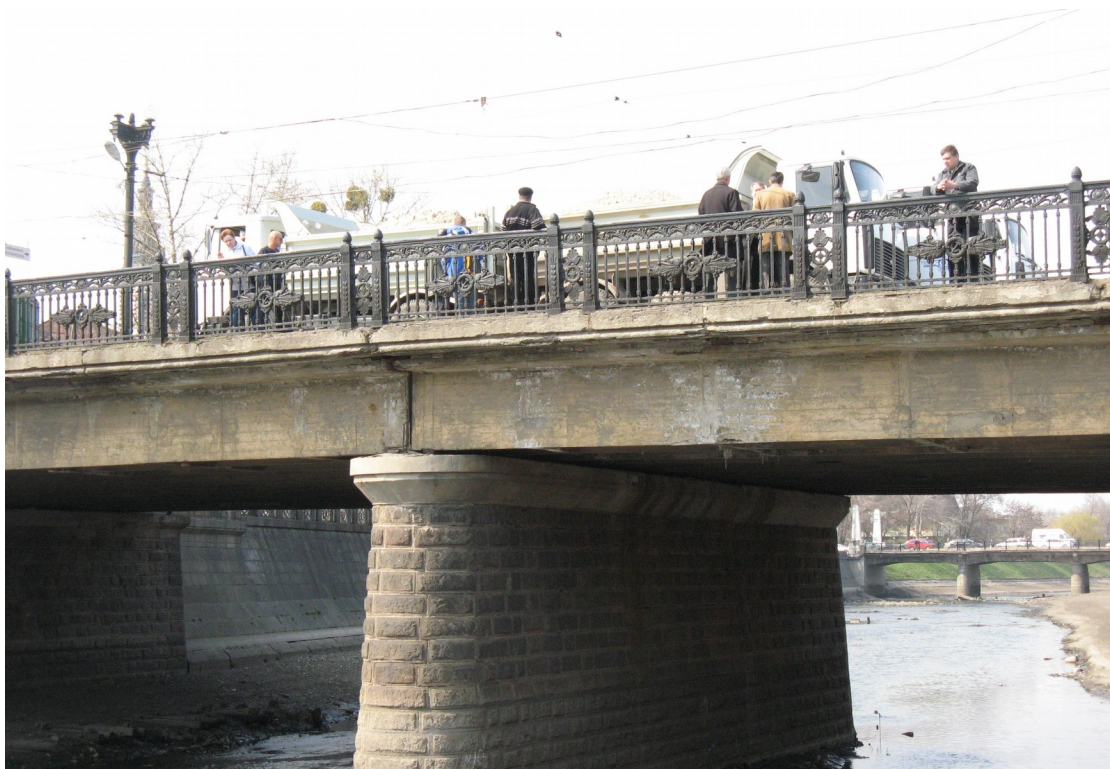
Рис. 43. Випробування Лопанського мосту в Харкові автомобілями МАЗ 555102-223, середня вага автомобілів 19,1 тс
