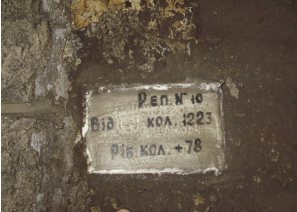
Рис. 105. Таблички, на яких фіксують положення рейкової колії в плані та профілі
