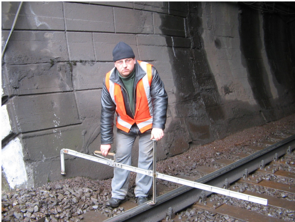
Рис. 104. Визначення положення рейкової колії в тунелі за допомогою тунельного шаблону
