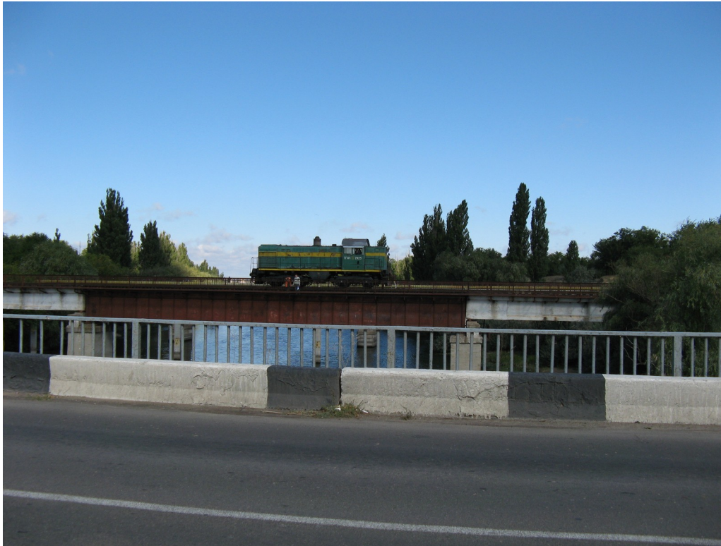
Рис. 49. Випробування металевої балкової прогонової будови з їздою зверху тепловозом ТГМ4-2425
