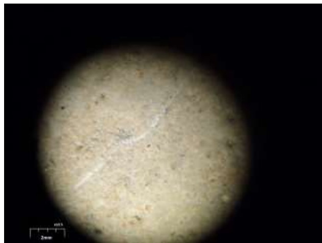
Рис. 5. Фрагмент трещины 2 из рис. 3, a (увеличение \times 12,5 )
