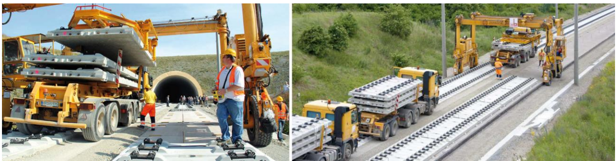
Рис.1 - Укладання плит на ділянці Єдиного транспортного проекту
